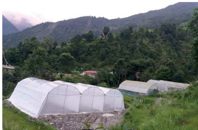
Blick auf die fertig gestellten Gewächshäuser
