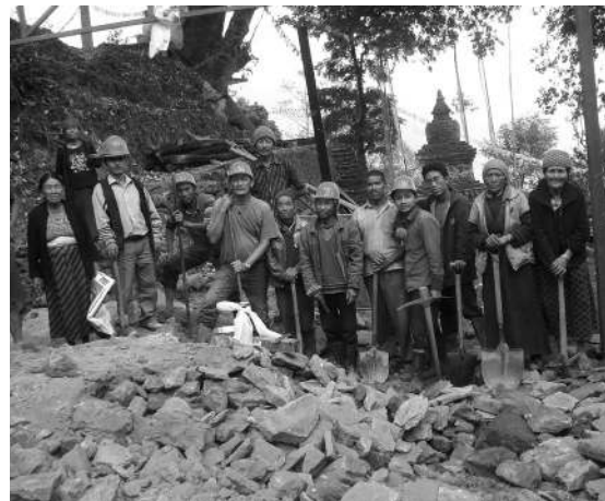
Die Bewohner packen an – doch es fehlt an Geld für Baumaterial und Ausrüstung.
